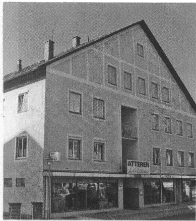
Das Atterer-Geschäftshaus an der Füssener Straße in Marktoberdorf vor der Sanierung....
